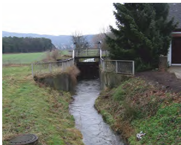
Stauwehr im Landbach vom Unterwasser
