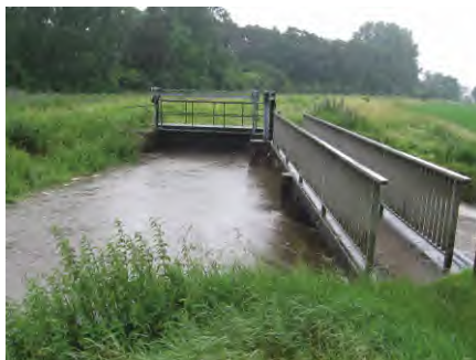
Sandbachwehr bei Hochwasser
