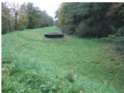
HRB Bickenbach mit Überlauf (Grünbecken)
