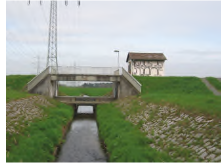
Regulierbauwerk im Sandbach mit Wehrklappe und Steg
