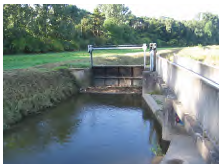
Sandbachwehr bei Niedrigwasser
